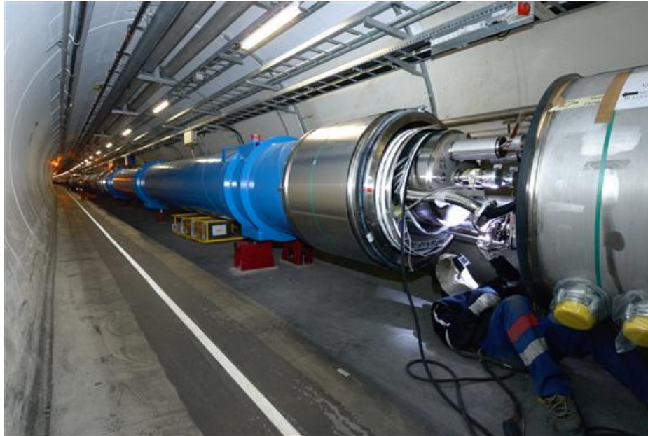
写真: LHC の最後のセクターにおける接続作業
