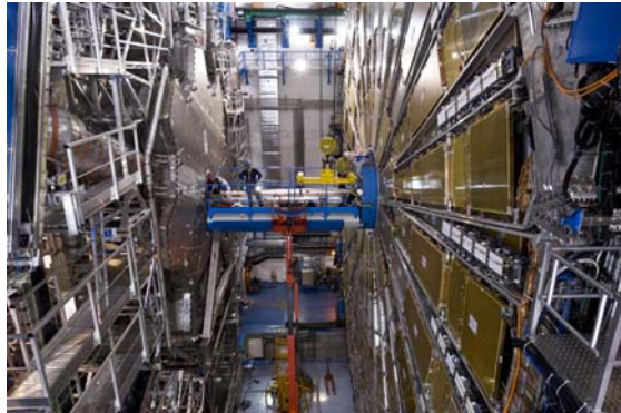
6月16日アトラス実験でLHC加速器の最後の要素のビームパイプが据付けられた。
