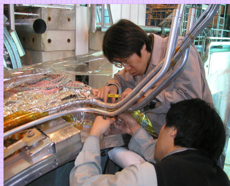
2004年3月 ガス配管とケーブルの配線作業
