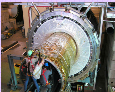
2004年2月26日 液体アルゴンカロリメーター内側へ挿入(すき間はわずか2-3mm!)
