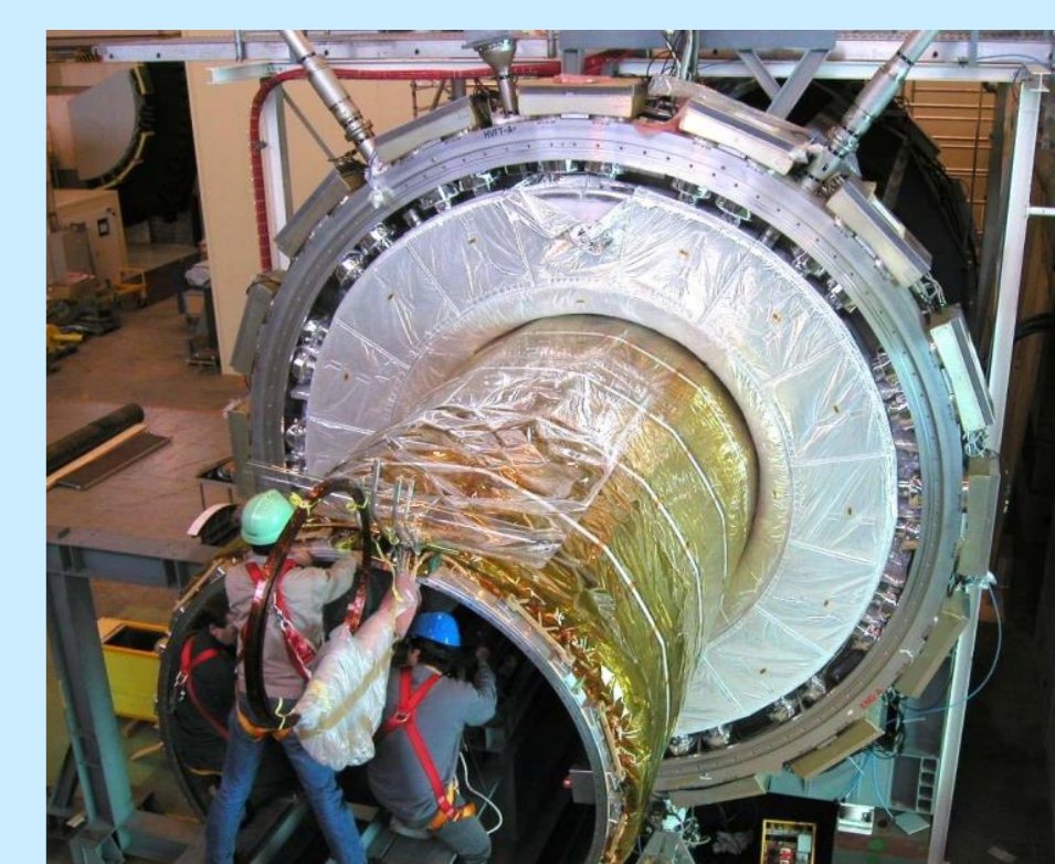
CERN地上で液体アルゴン低温保持装置へ据付(2004)
