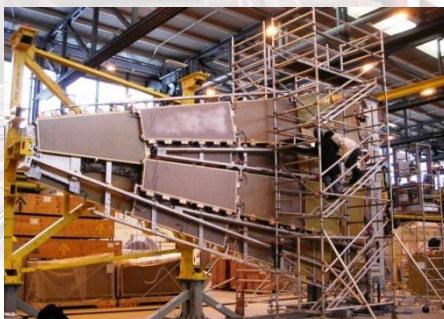
CERNでのセクター組立と回路据付 (2005-2007年)
