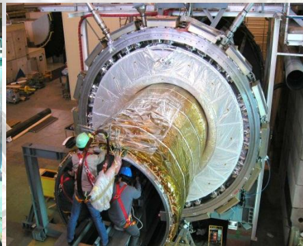
2004.2 液体アルゴンカロリメーター容器への挿入作業。
