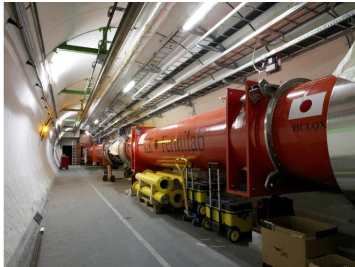
LHCトンネル内に設置された超伝導四極磁石
